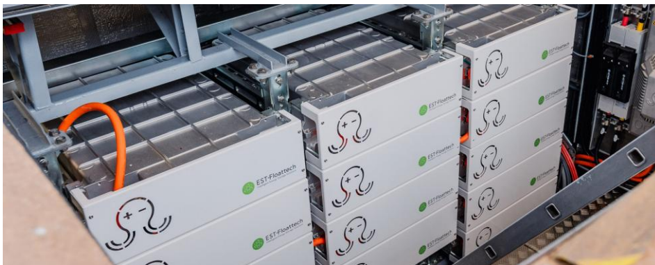
Foto: voorbeeld van een modulair compact Octopus-Lite systeem in een ship onder het dek uit 2025
