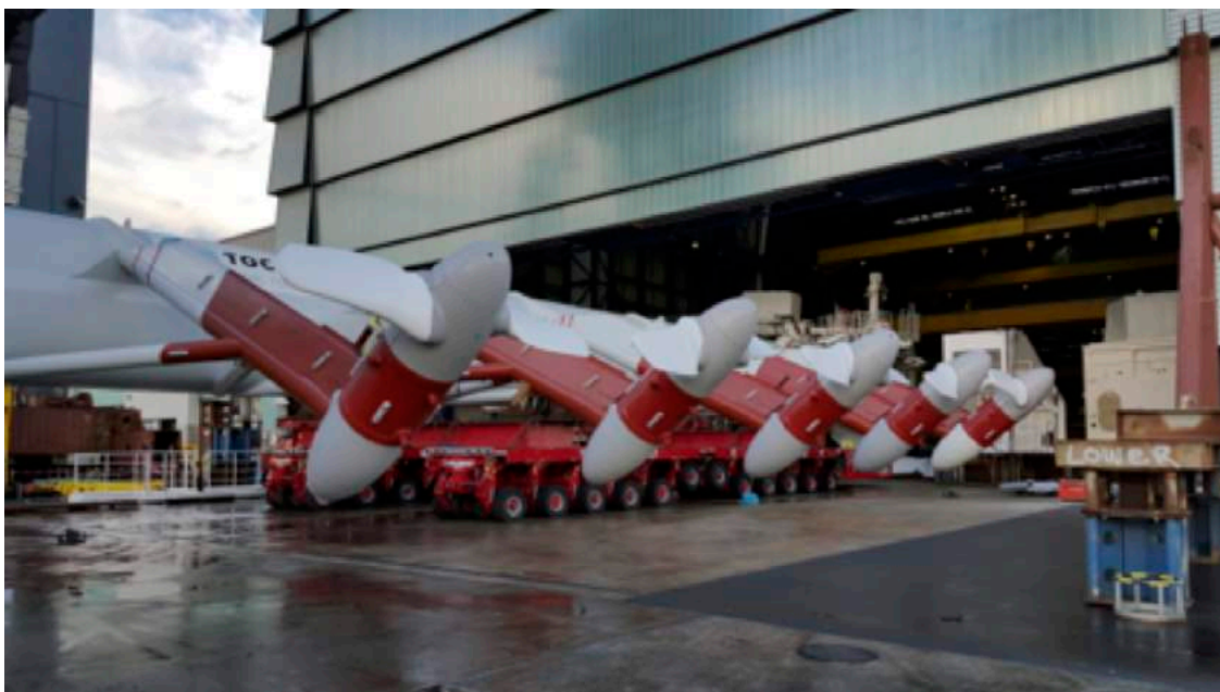
Foto: load out van de Oosterschelde getijdeninstallatie door Mammoet
