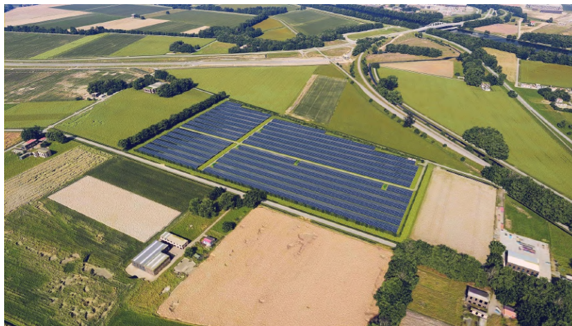
Figuur 13: Zonnepark Bontepolder waar de batterij geplaatst gaat worden (copyright Solarfields).
