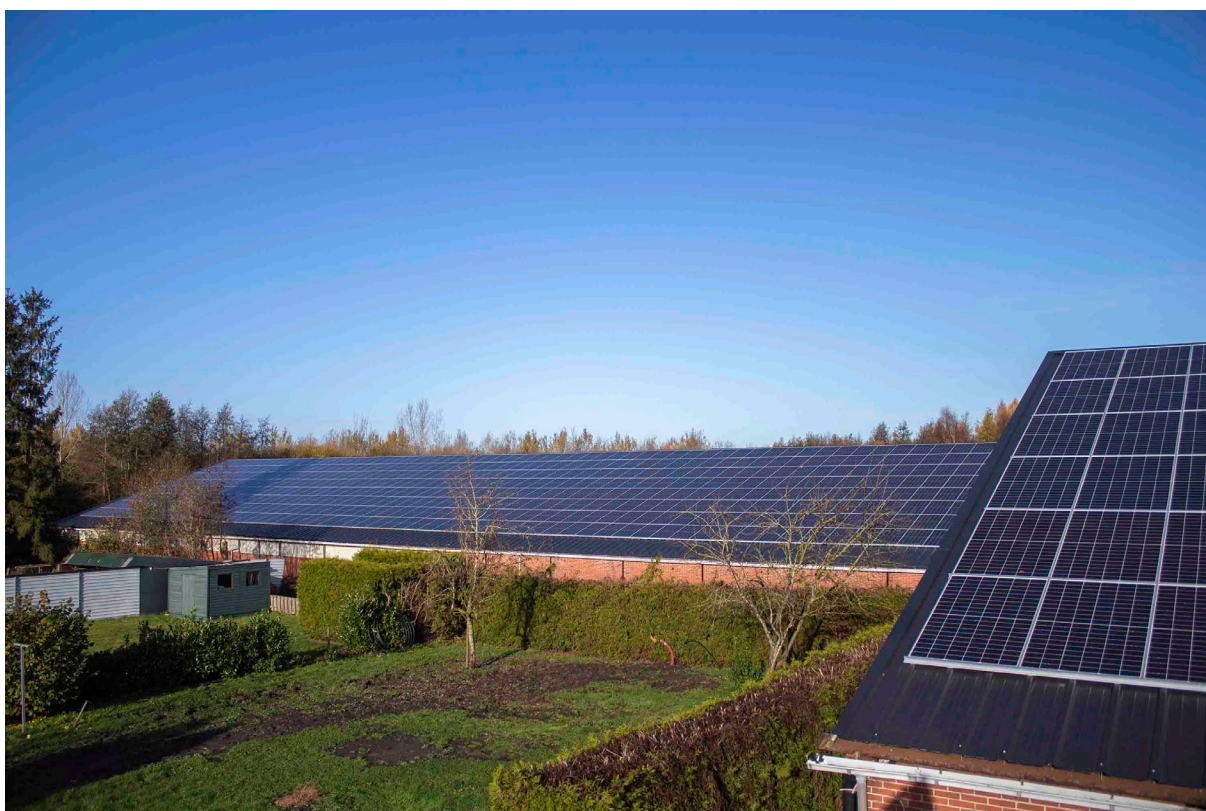
Foto: Volgroen Zonnestroomsysteem van 340 kWp in Zwartemeer
