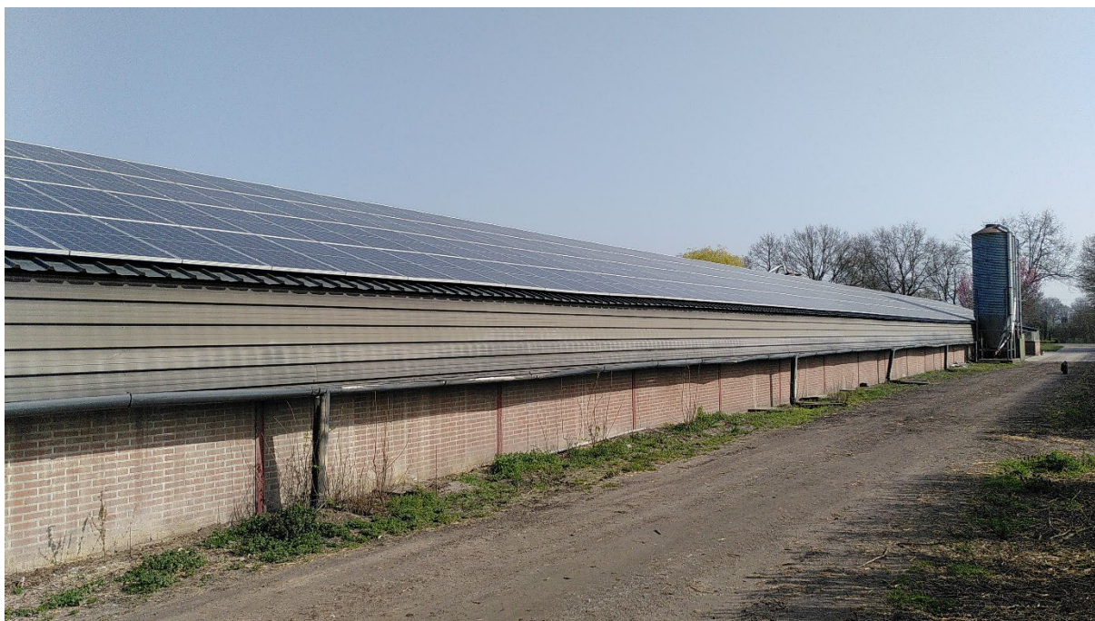
Foto: Volgroen Zonnestroomsysteem van 160 kWp bij een pluimveehouderij.
