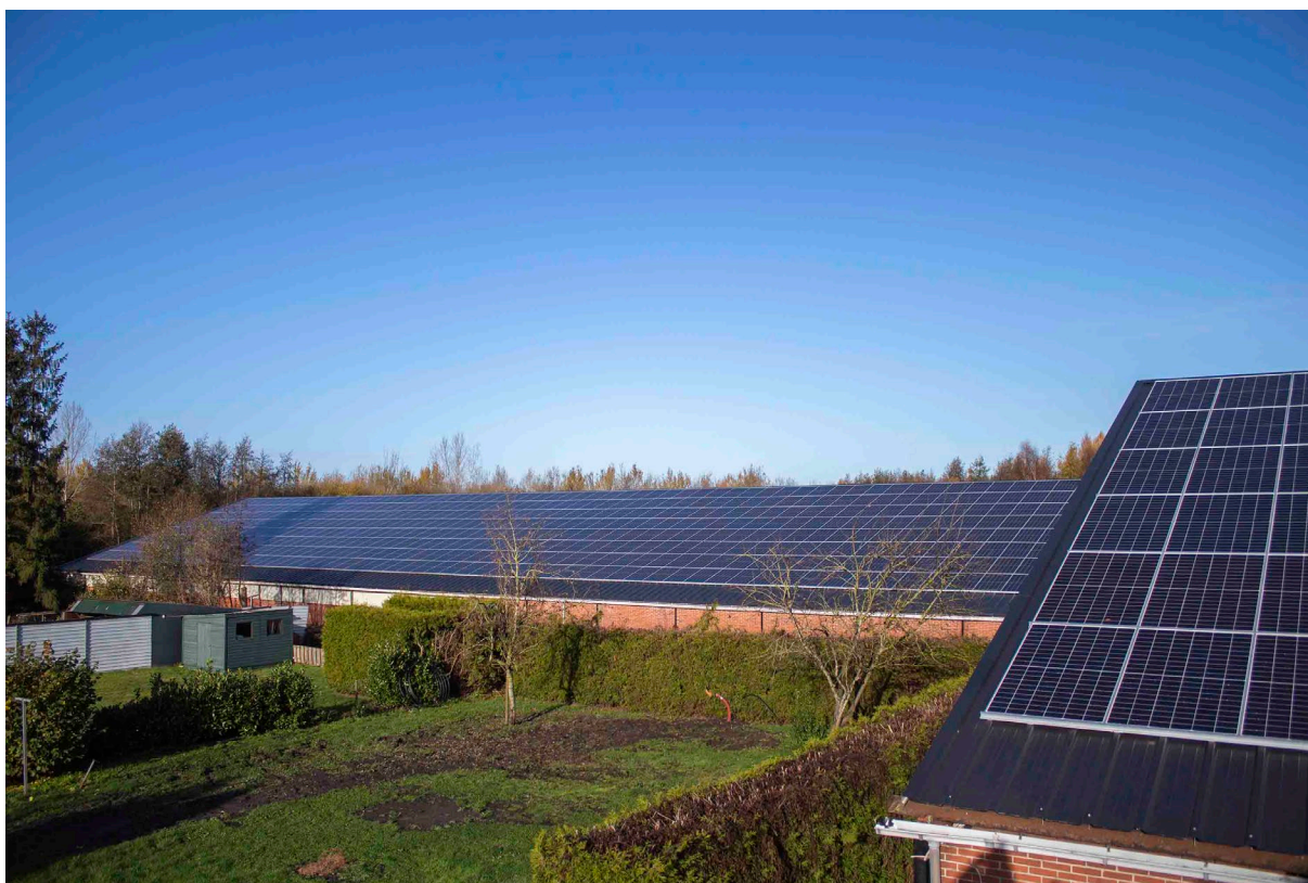
Foto: Volgroen Zonnestroomsysteem van 340 kWp in Zwartemeer
