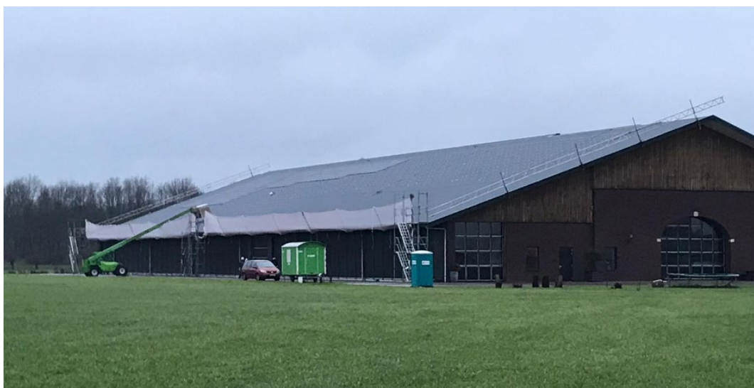
Foto: zonnedak in aanbouw locatie Gelderland
