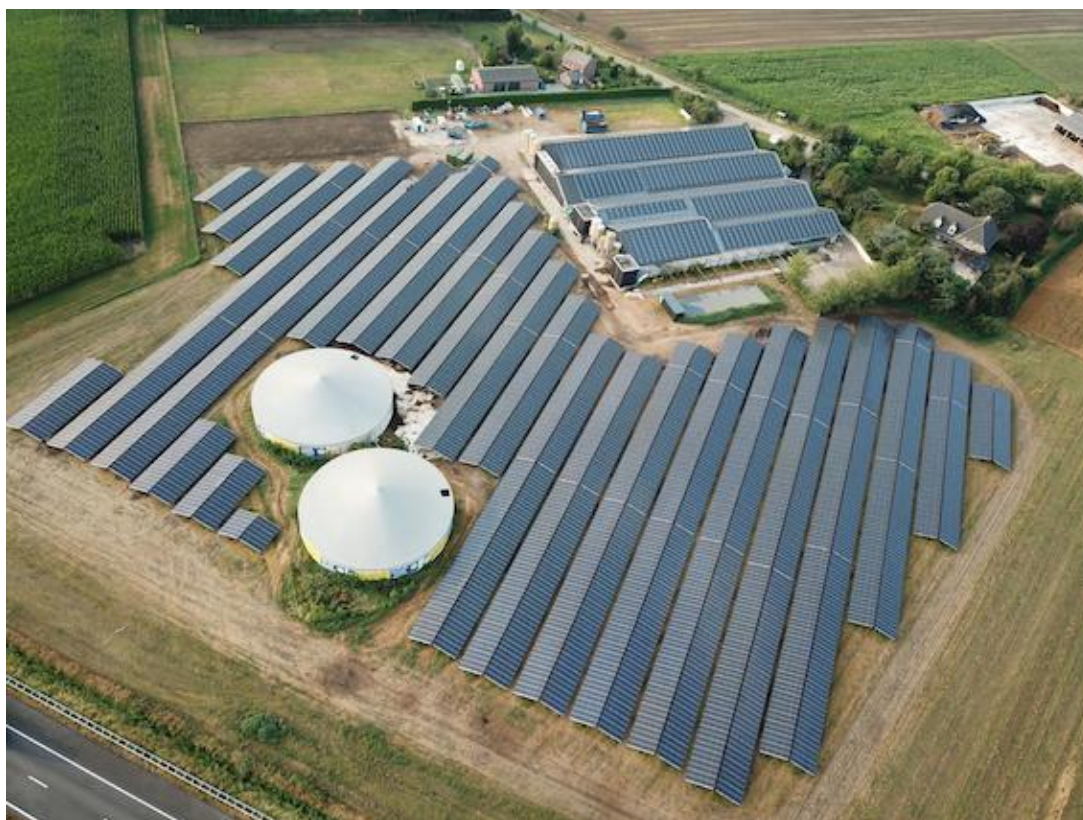
Bovenaanzicht van het gerealiseerde zonnepark langs de A2 te Weert.
