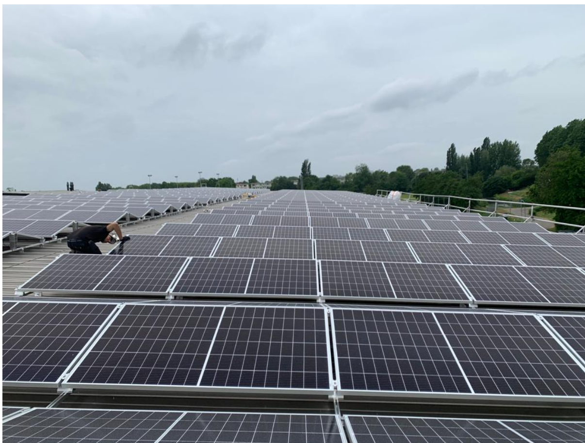
Foto: zonnepanelen op de Reeweghal
