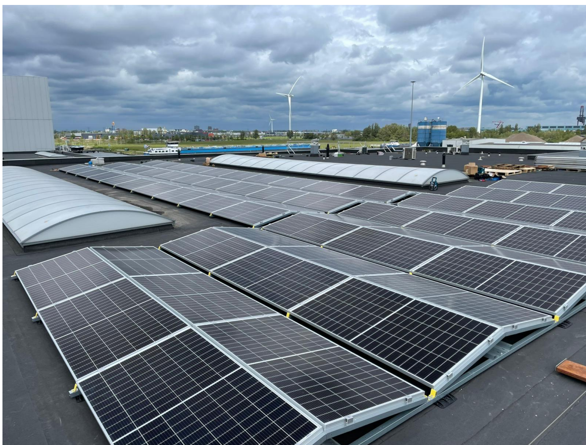
Figuur 1, Het Zonnestroomsysteem Struyk Verwo in aanbouw op locatie
